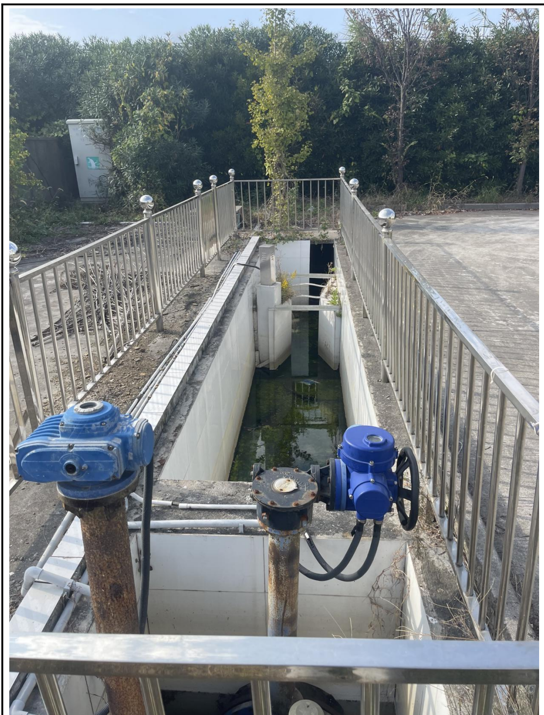
雨水池整体情况
