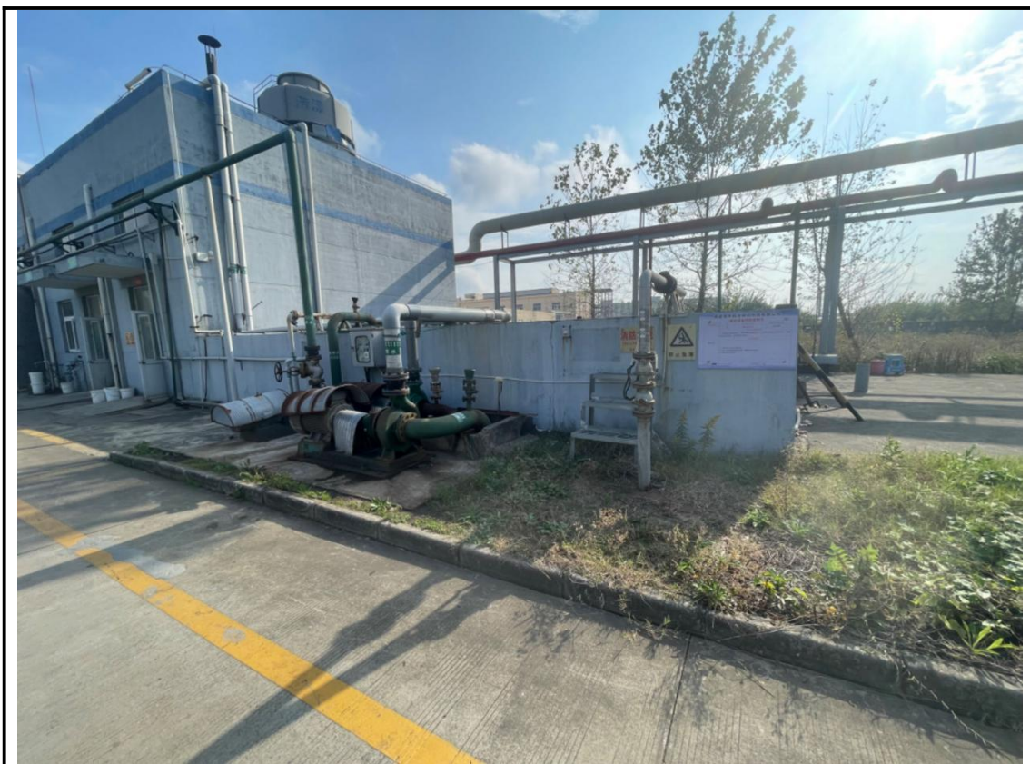
消防水池现场踏勘图
