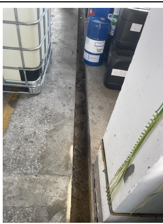
生产车间四导流槽
