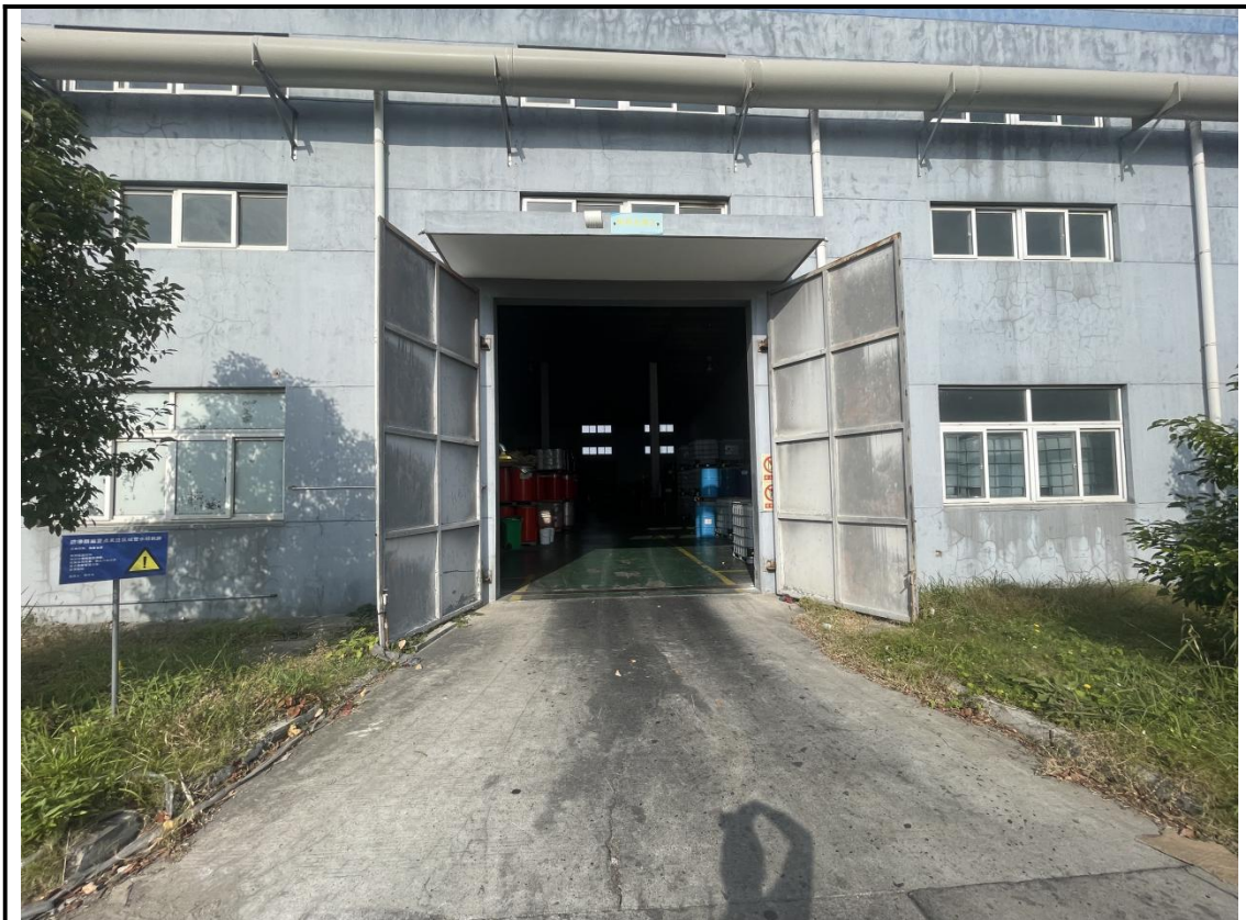
丙类仓库三外部整体情况
