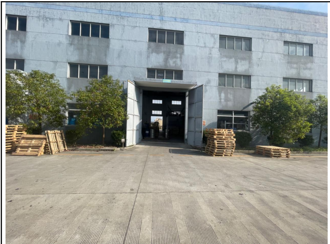
生产车间四外部整体情况
