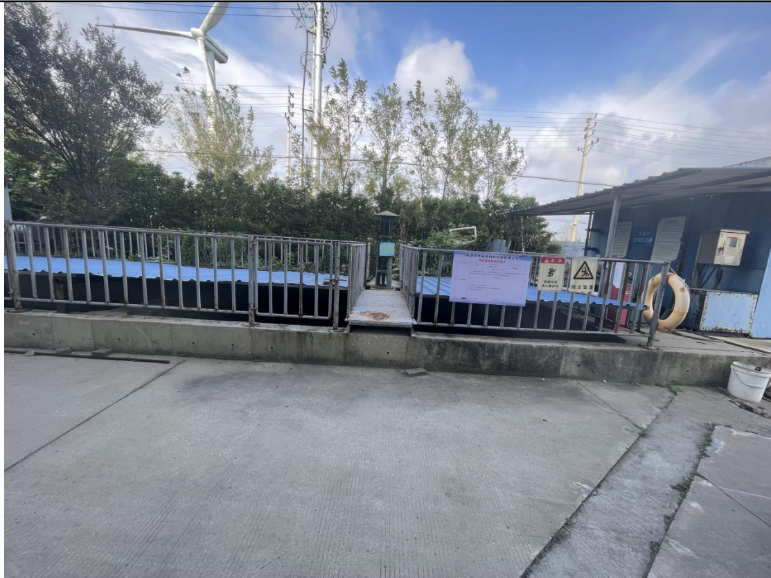
污水处理区外景全貌图
