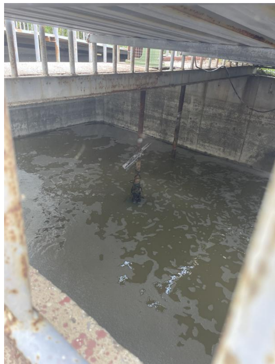
池体墙面情况
