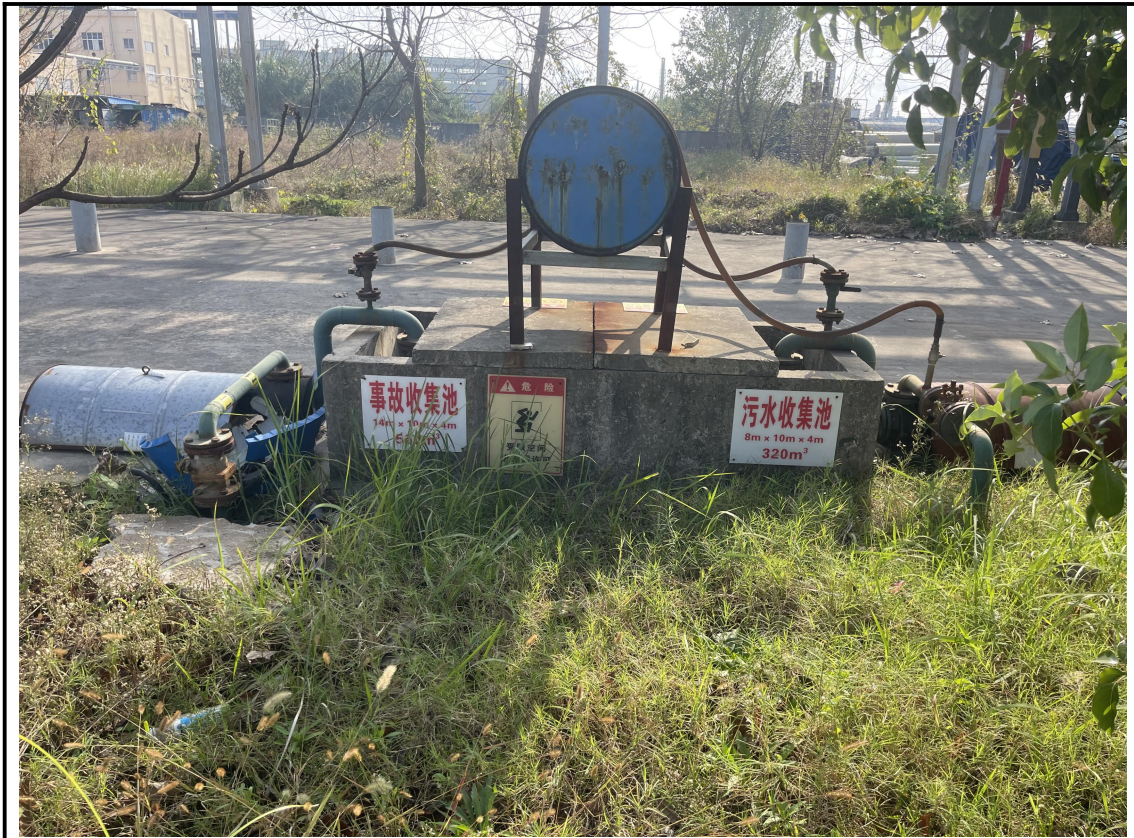
废水收集池现场踏勘图
