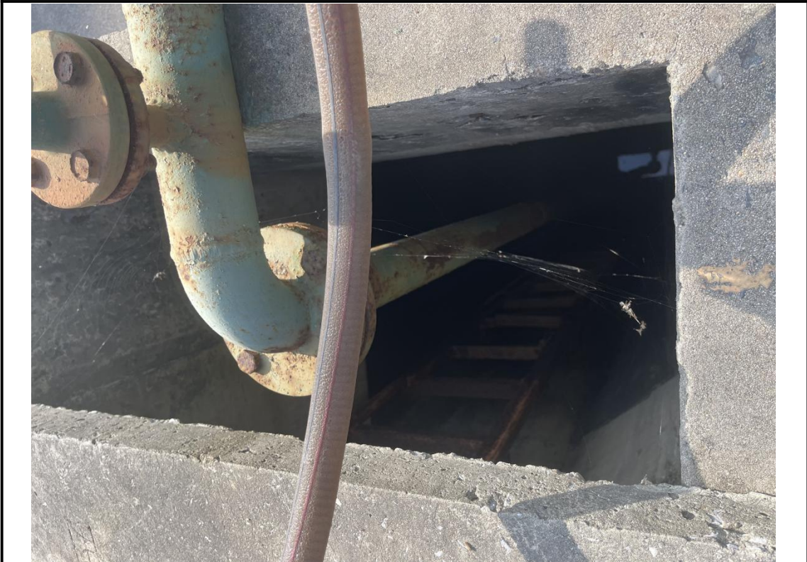
管道建设情况
