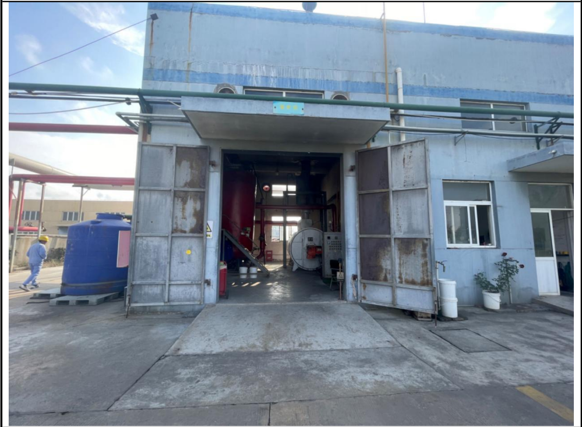
导热油炉车间外部整体情况
