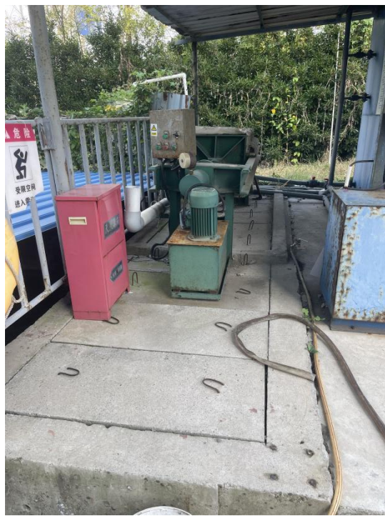
管线建设情况
