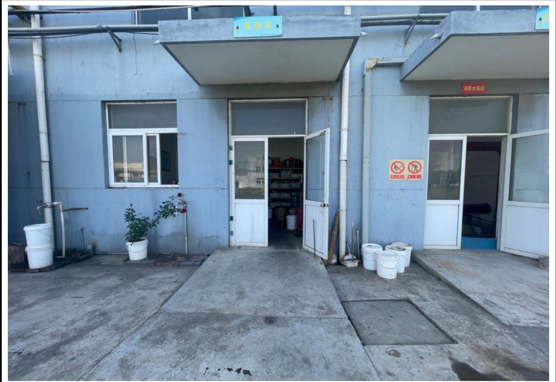
机修车间现场踏勘-外部全貌
