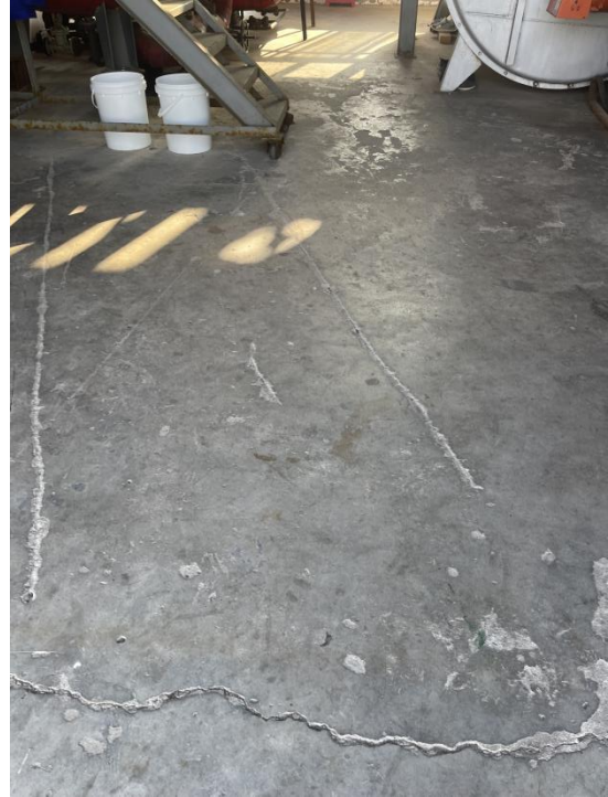
机修车间地面硬化情况
