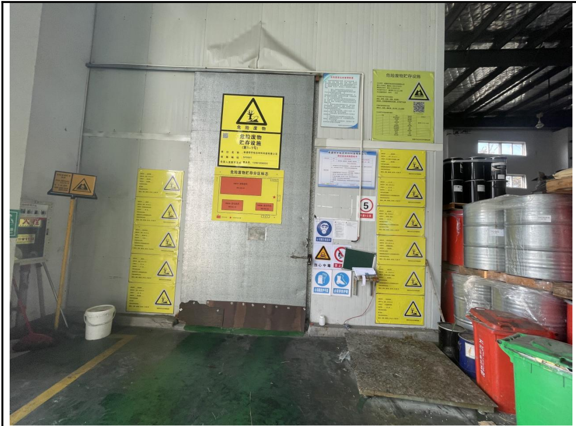
危废仓库外部整体情况
