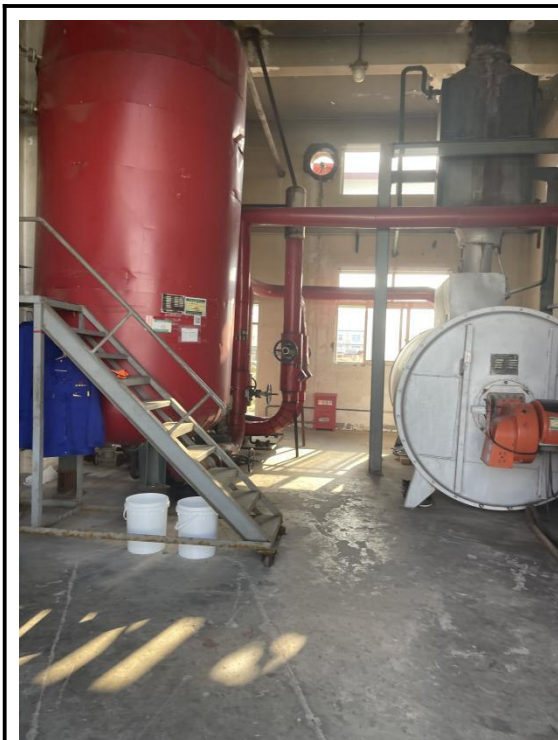
导热油炉车间内部整体情况
