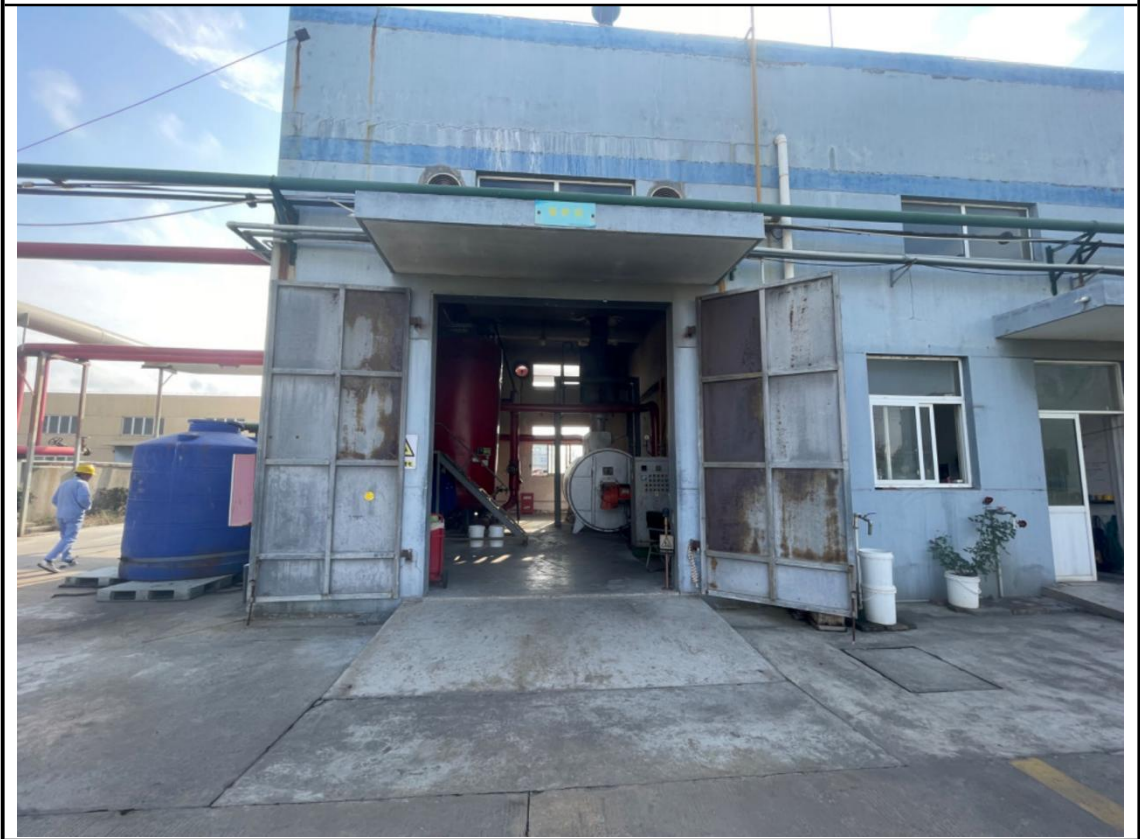
导热油炉车间外部整体情况
