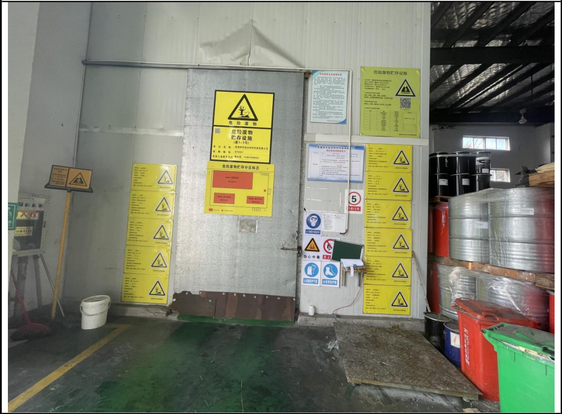
危废仓库外部整体情况
