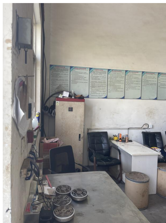
机修车间墙面情况
