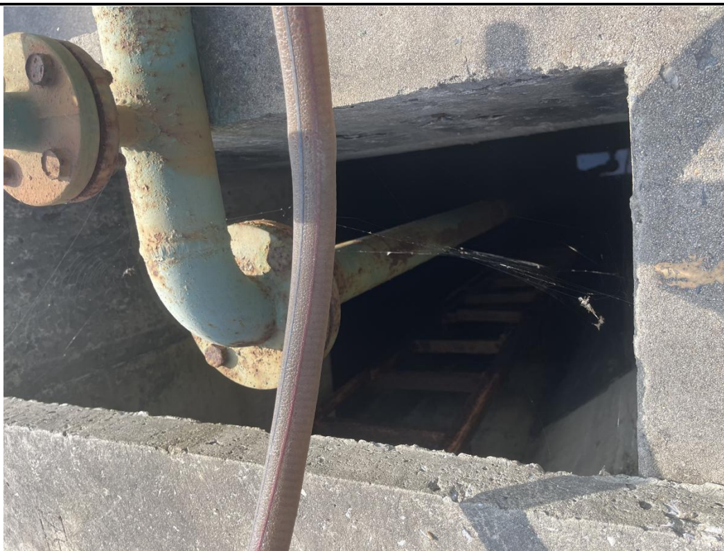
管道建设情况
