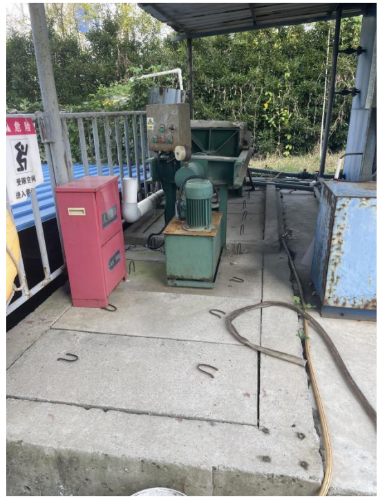
管线建设情况
