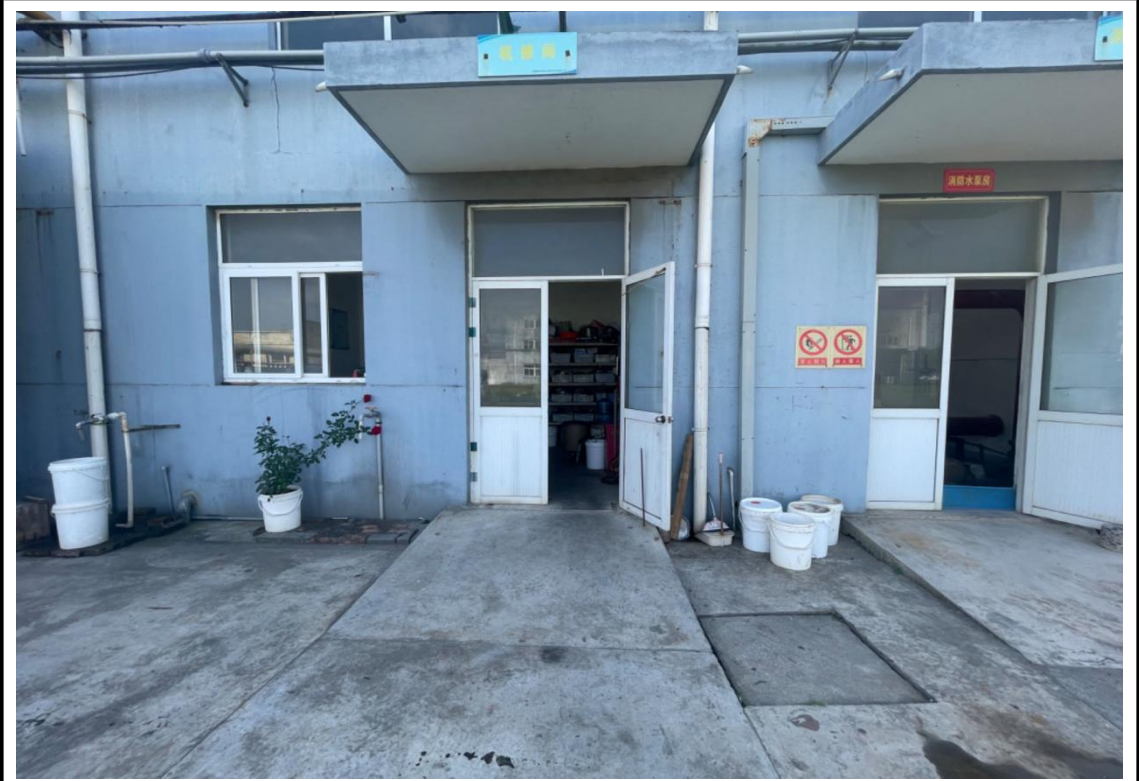
机修车间现场踏勘-外部全貌
