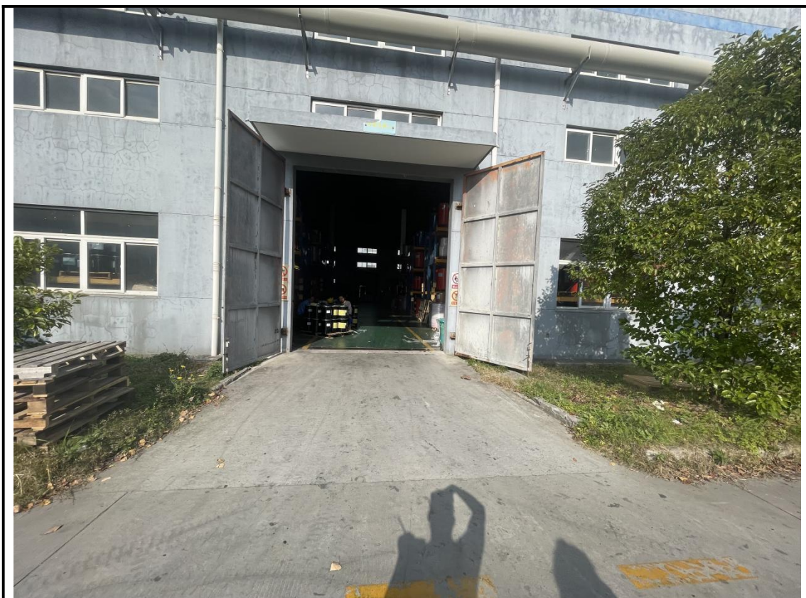
丙类仓库二外部整体情况
