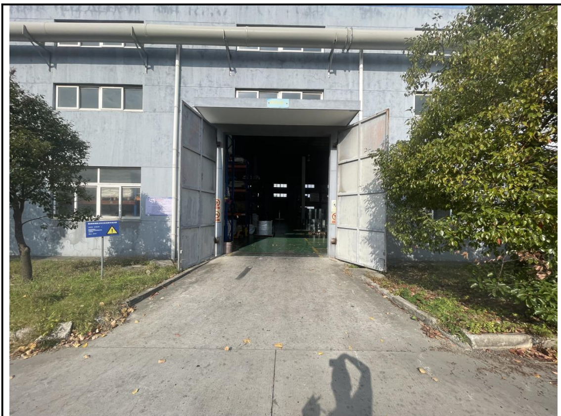
丙类仓库一外部整体情况
