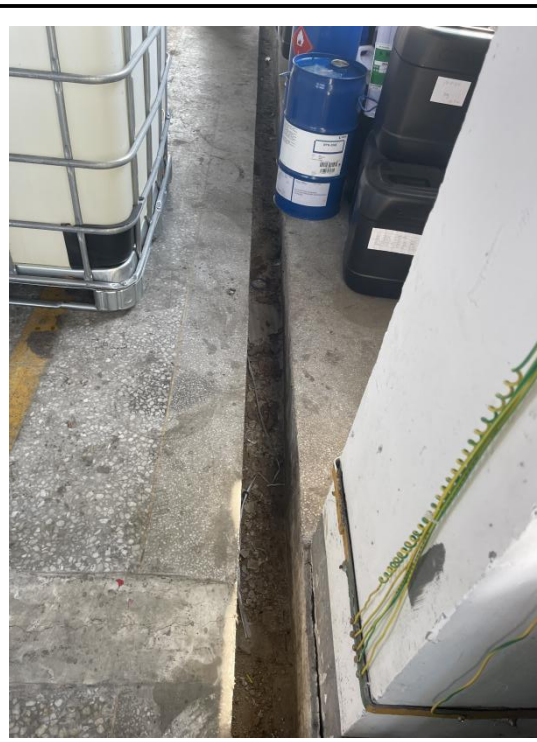
生产车间四导流槽
