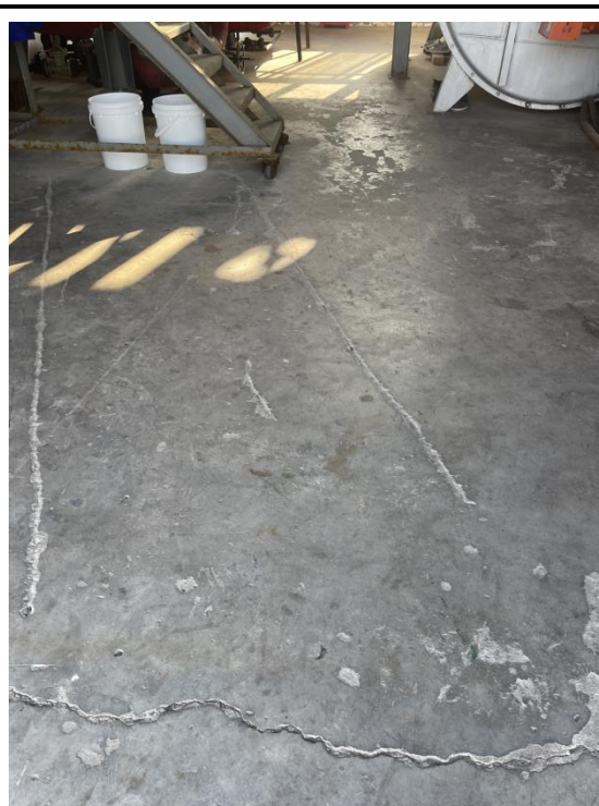
机修车间地面硬化情况
