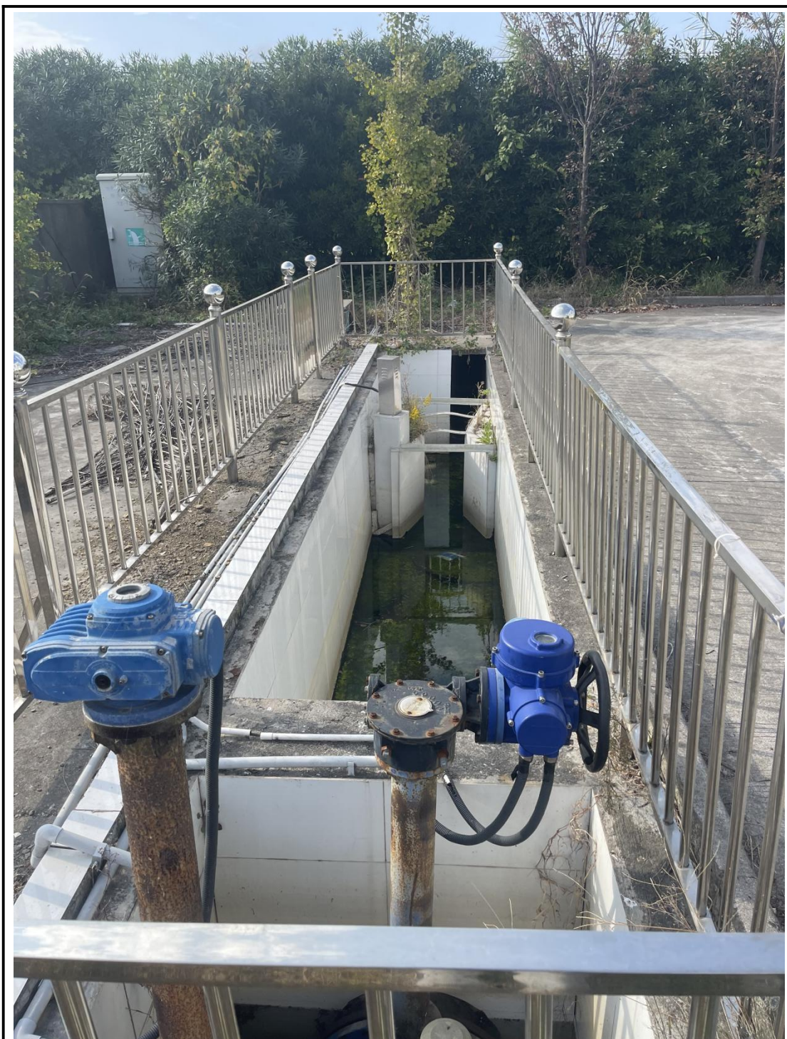
雨水池整体情况
