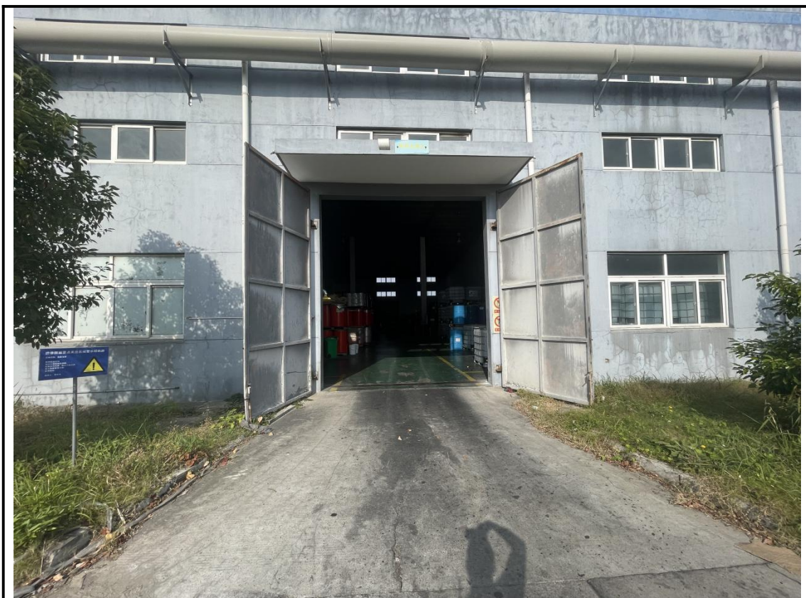
丙类仓库三外部整体情况
