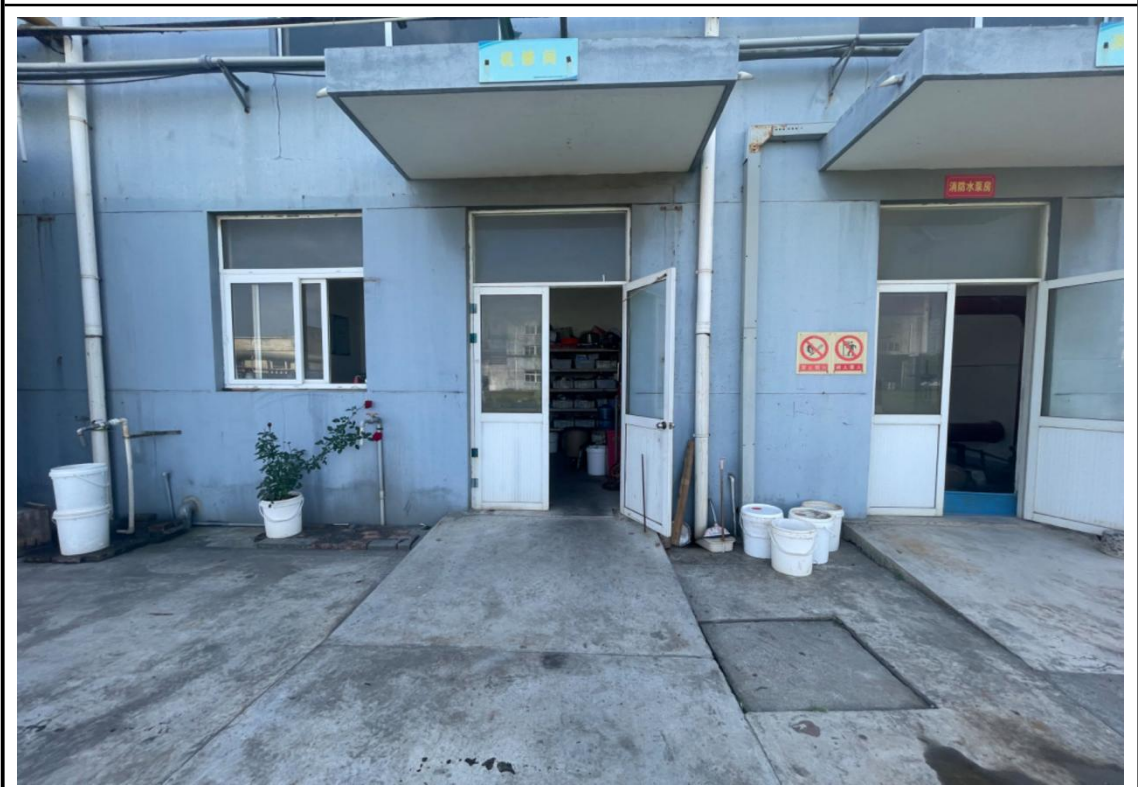
机修车间现场踏勘一外部全貌
