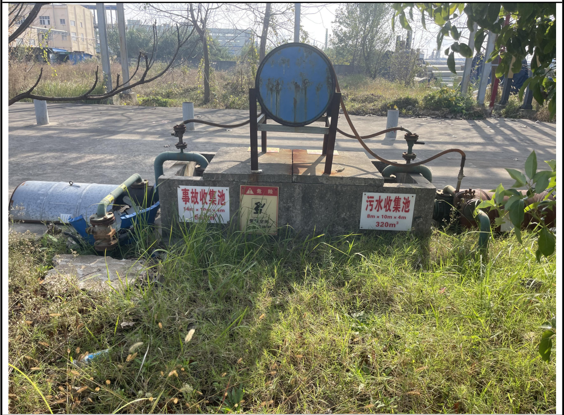
事故应急池外景全貌图
